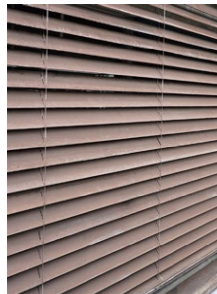
7年経過 / 庇無し / メンテナンス無し
