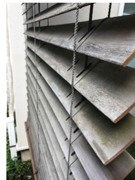
15年経過 / 庇無し / メンテナンス無し
